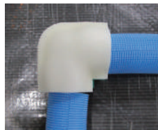
継手用保温材の取付
