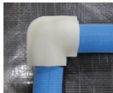
継手用保温材の取付
