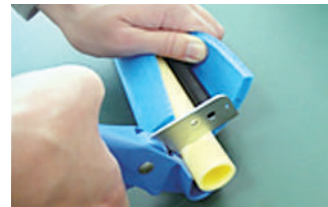
パイプのカット
