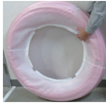
切欠きから手を差し込み、 内周融着部のフィルムを 開いていきます。
