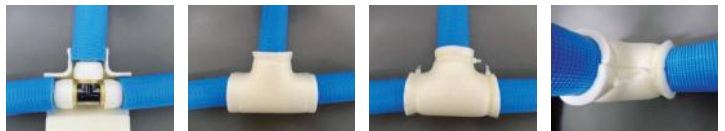
継手用保温材にセット 継手用保温材に取付 結束バンドにて固定 継手用保温材の隙間確認
